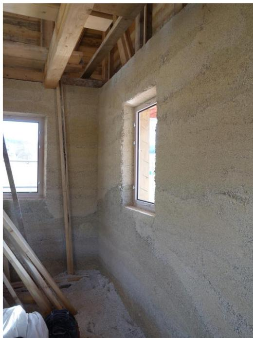
Abbildung 10: Innendämmung ausgeschalt
