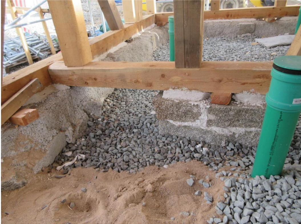
Abbildung 12: Streifenfundament auf Frostschuttschicht
