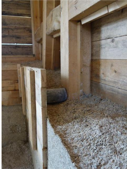
Abbildung 11: Außenwandaufbau im Dämmprozess
